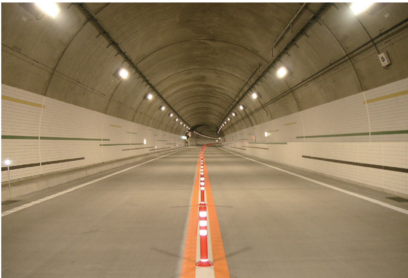
中部縦貫自動車道小鳥トンネル 使用タイル：NW-942/CT-白（特色）
